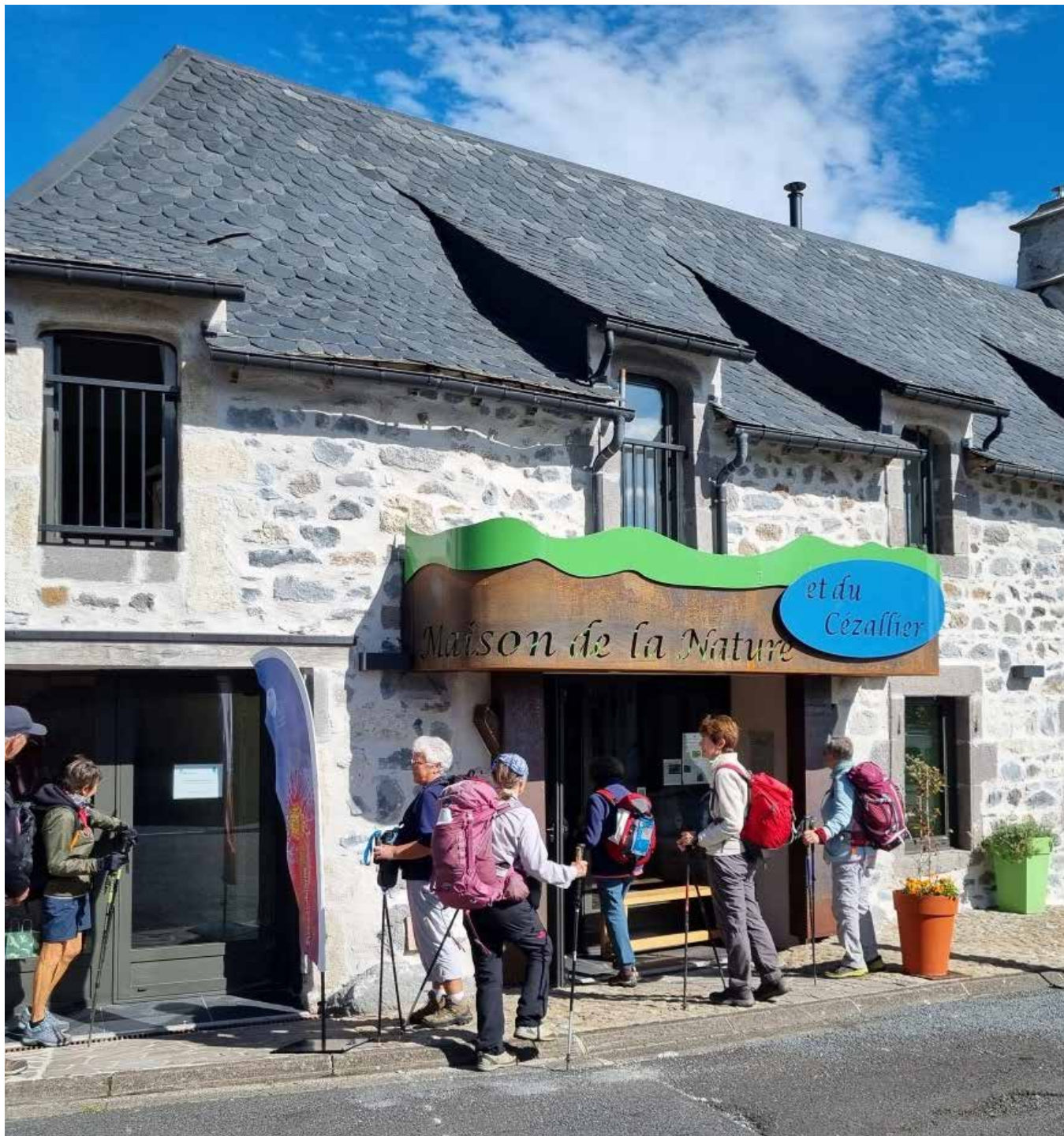
Maison de la Nature et du Cézallier - Après rénovation.
